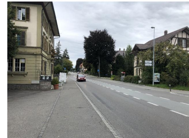
Bild 1: Abschnitt mit Mehrzweckstreifen auf Höhe Kantonspolizei (Querschnitt von rund 12.5m)
