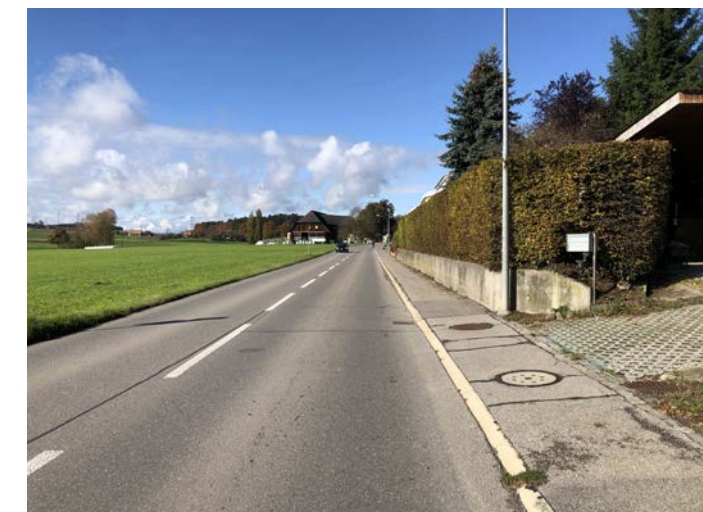
Bild 2: Meikirchstrasse, Ortseinfahrt Schützenrain
