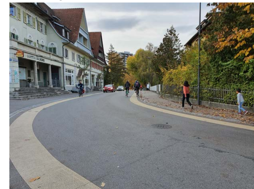
Beispiel einer umgestalteten Strasse mit ÖV in Wabern.
