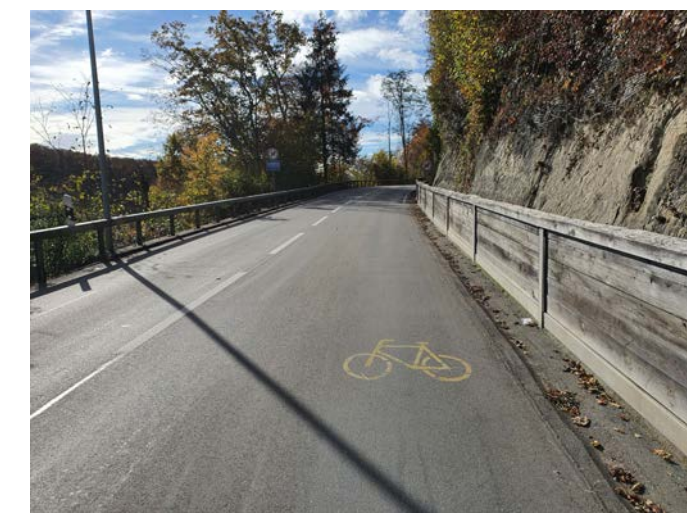
Bild 1: Uettligenstrasse Blick Richtung Uettligen
