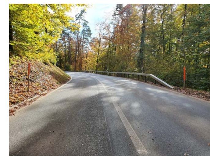
Bild 1: Uettligenstrasse Blick zurück Richtung Halenbrücke
