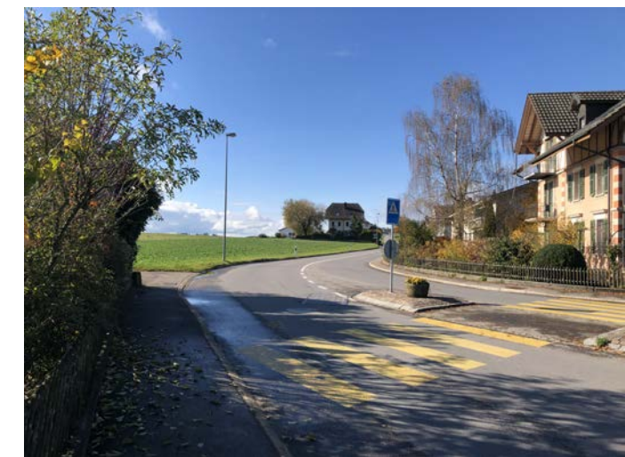
Bild 1: Uettligenstrasse Blick Richtung Uettligen
