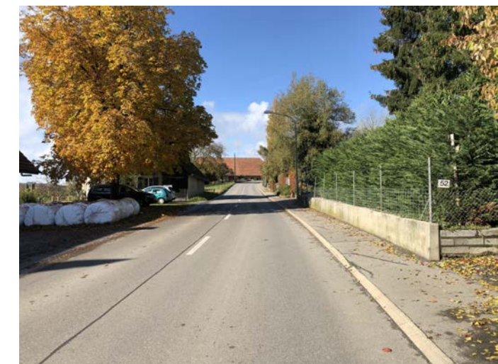
Bild 1: Meikirchstrasse Blick Richtung Meikirch
