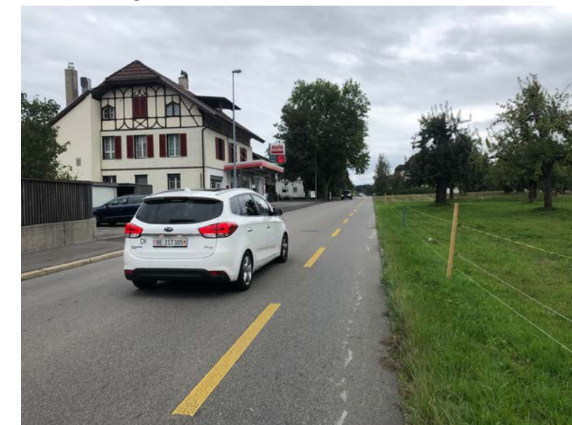
Referenzbild Kernfahrbahn mit Radstreifen (Münchenbuchsee)
