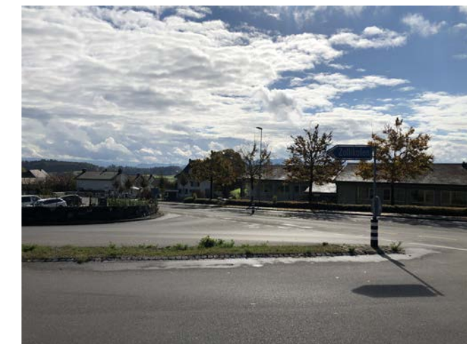
Bild 1: Übergrosse Einmündung im Knotenbereich
