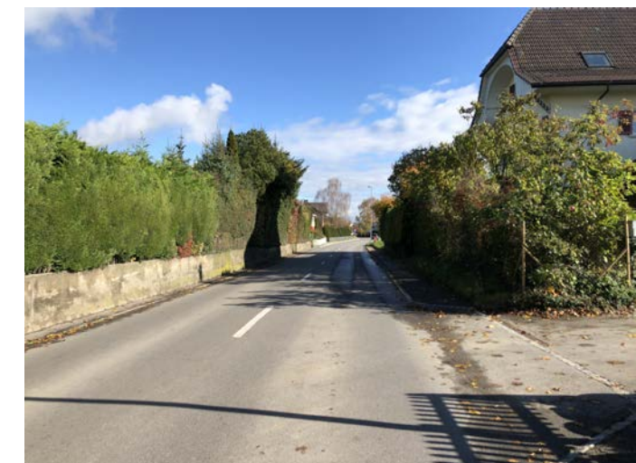
Bild 2: Uettligenstrasse Blick Richtung Uettligen
