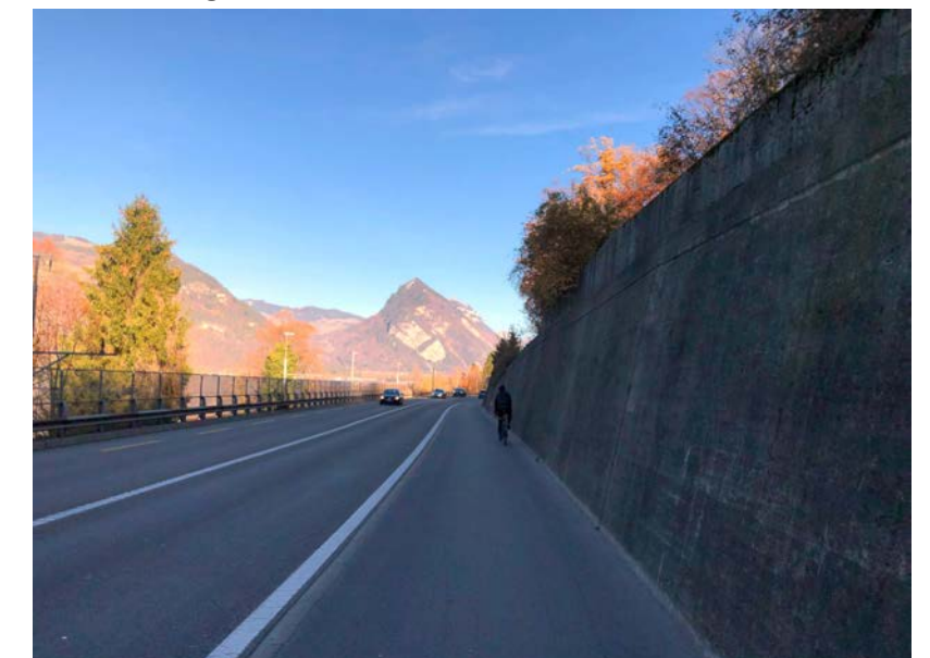
Referenzbild: Radweg mit baulicher Abtrennung zur Strasse (Interlaken)
