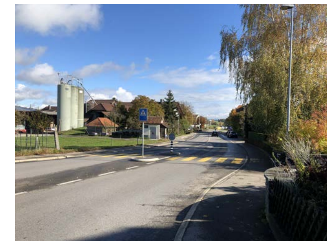
Bild 2: Knoten Blick auf die Querungsstelle
