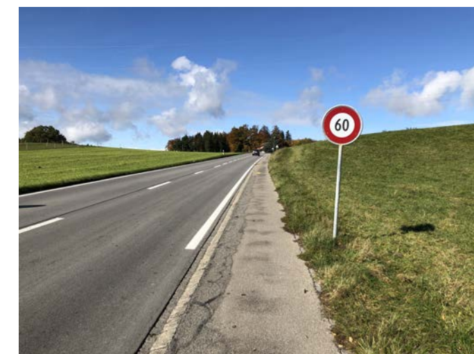
Bild 1: Bernstrasse (Abschnitt mit Fussweg)
