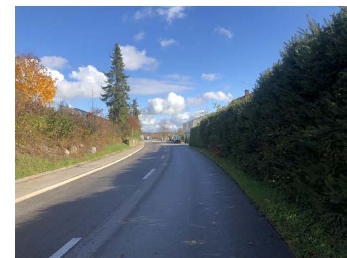
Bild 2: Kirchlindachstrasse Blick Fahrtrichtung Kirchlindach
