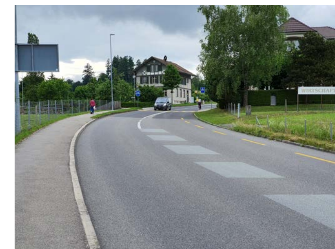
Bild 1: Bernstrasse Blick Richtung Kurve
