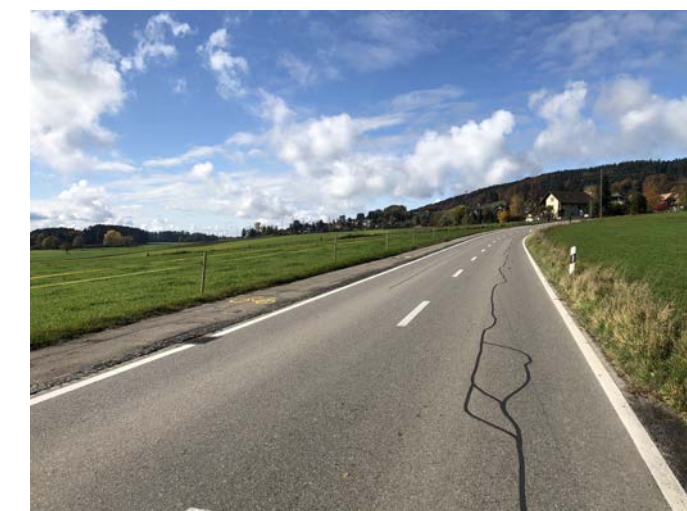
Bild 1: Bernstrasse Blick Richtung Meikirch mit bestehendem Fuss-/Radweg in Fahrtrichtung Bern.
