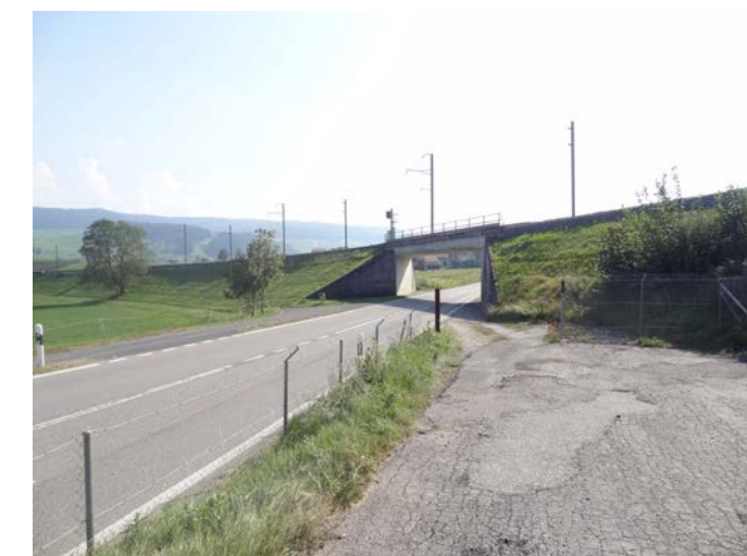
Bild 1: Bahnunterführung Kantonsstrasse, Blick Richtung Konolfingen
