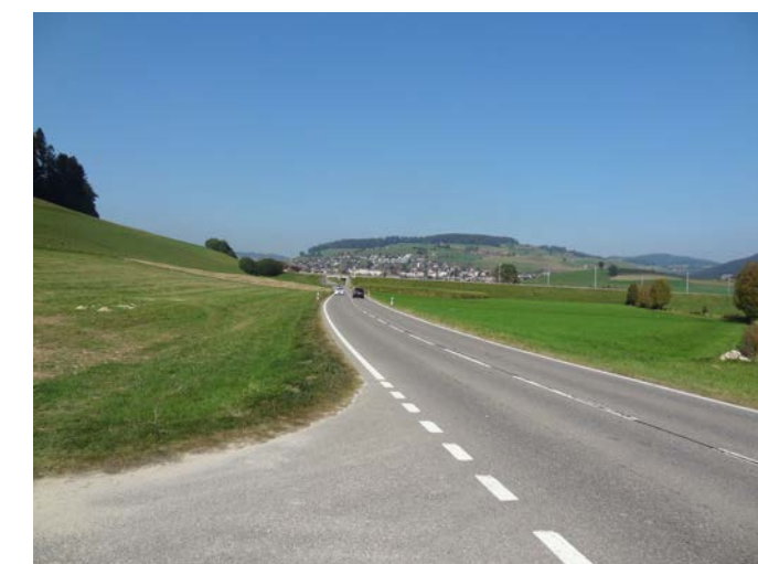
Bild 2: Kantonsstrasse Blick Richtung Grosshöchstetten
