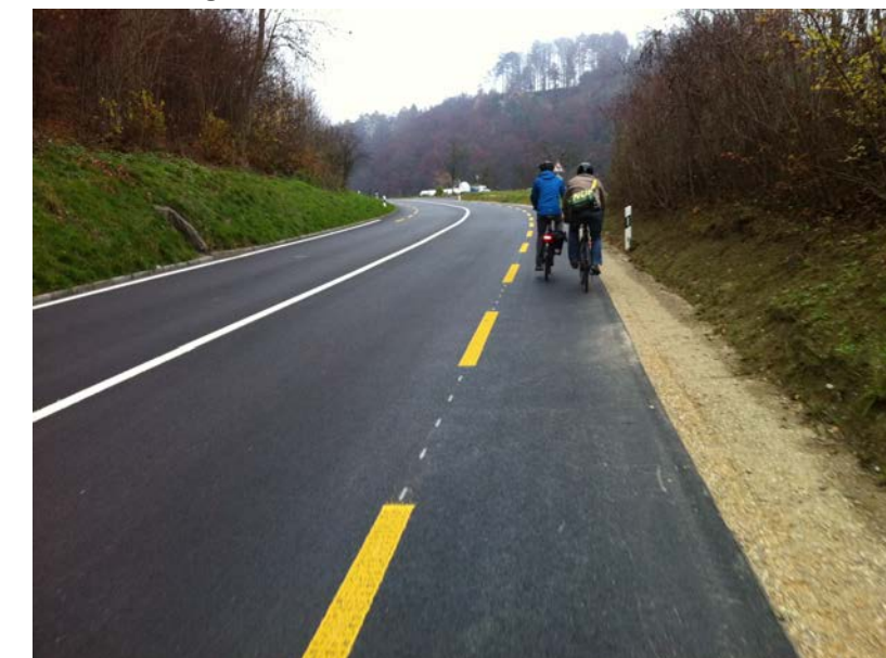
Referenzbild: Radstreifen bei Grafenscheuren (teils nur in Richtung der Steigung, teils beidseitig)
