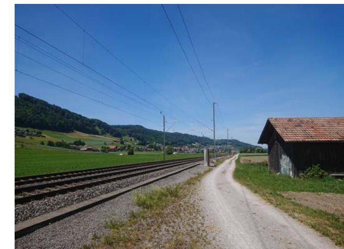
Bild 2: Kanalweg Richtung Kaufdorf
