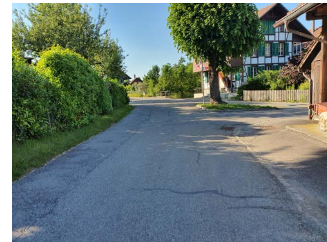
Bild 2: Knoten Moosstrasse / Neumattstrasse
