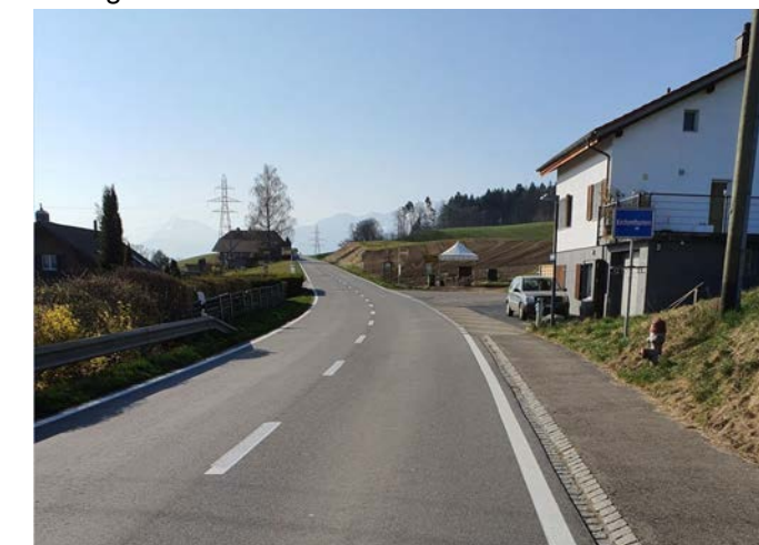
Bild 2: Riggisbergstrasse, Ende des freizugebenden Trottoirs in Kirchenthurnen
