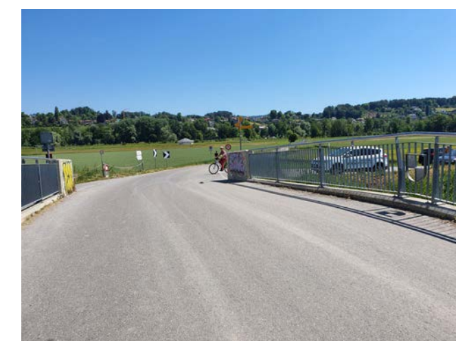
Bild 2: Ungenügende Sicht auf die Einmündung der Selhofenstrasse
