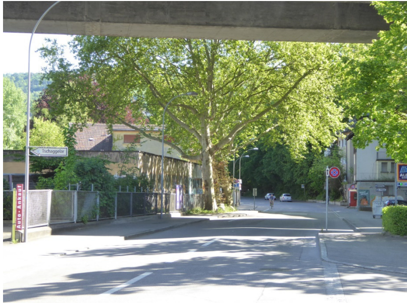
Abbildung 29: Heutige Situation im Bereich der geplanten Haltestelle Gaswerk Nord unter der Monbijoubücke
