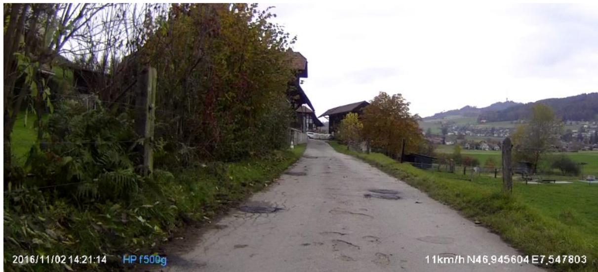
Abbildung 9: Der Deckbelag muss für die Alltagsveloroute abschnittsweise erneuert werden. Beispiel: Strassenzustand Nesselbank.
