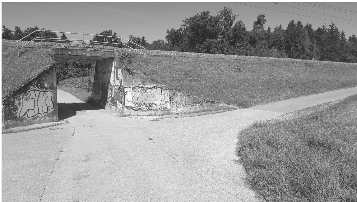
Abbildung 44: Unterführung (Sicht Richtung Norden)
