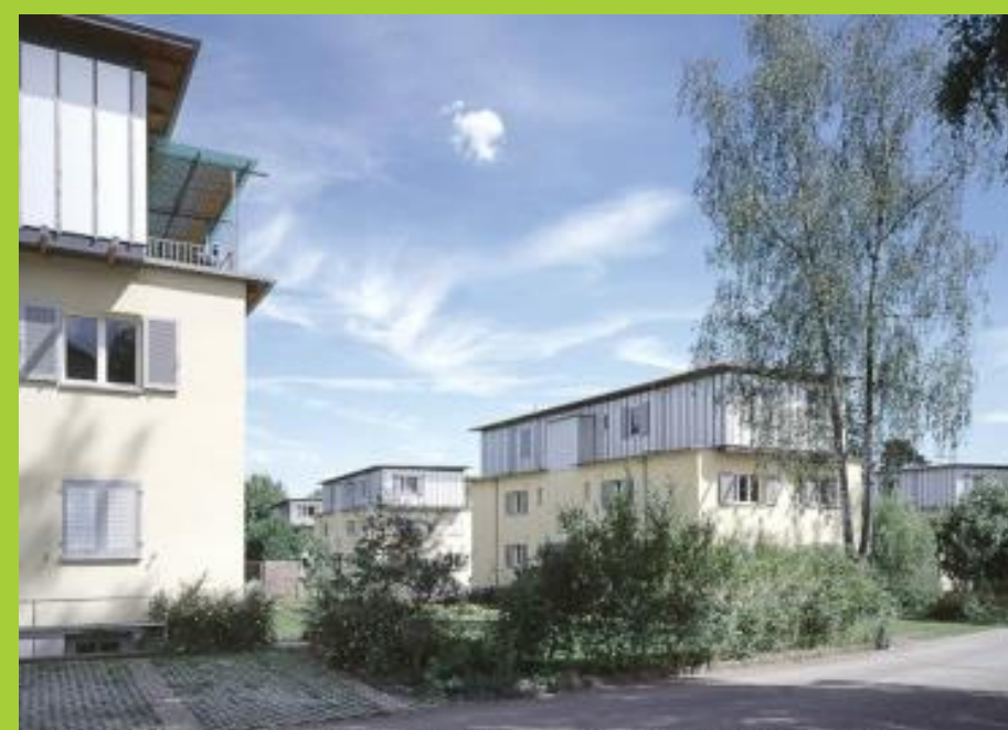
Aufstockung Siedlung Hofmatt, Solothurn. Jürg Stäubli Architekten
