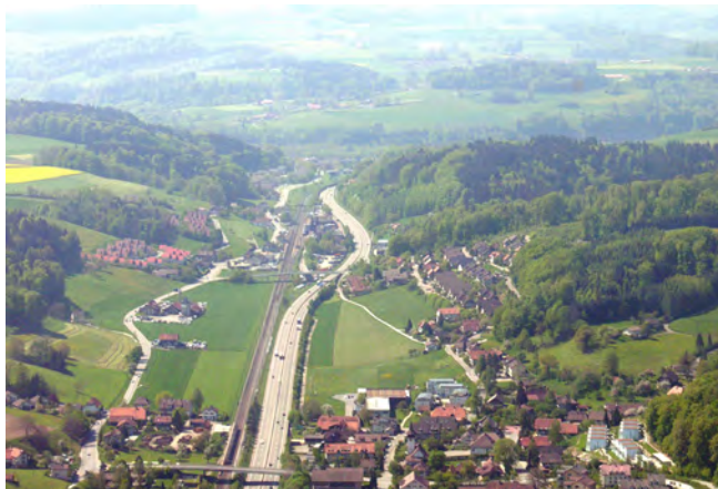
Abb. 39: Wangental bei Oberwangen: Lebensqualität trotz Einwirkungen der gebündelten Verkehrsträger ermöglichen.
